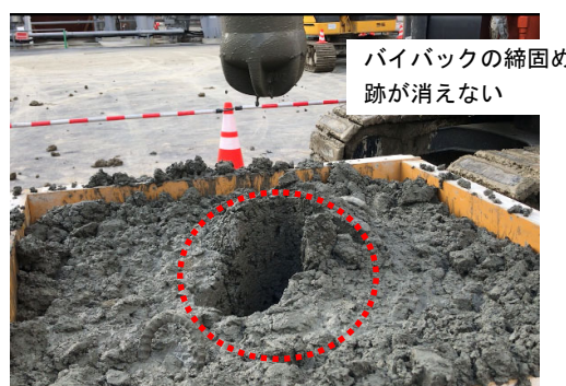
写真-1 コンクリートの締固め状況 (打込みから1時間後)
