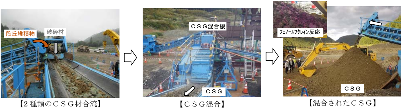
写真－4 C S G混合状況
