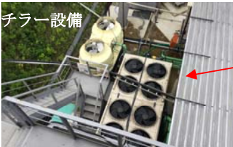
写真-1 冷却設備（骨材貯蔵設備、コンクリート製造設備）
