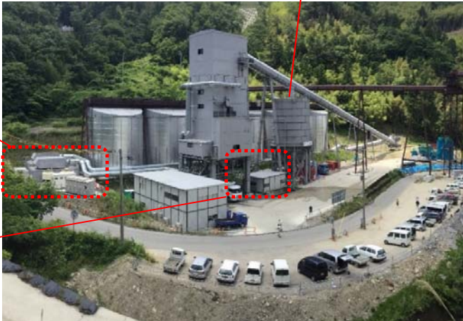
写真-1 冷却設備（骨材貯蔵設備、コンクリート製造設備）
