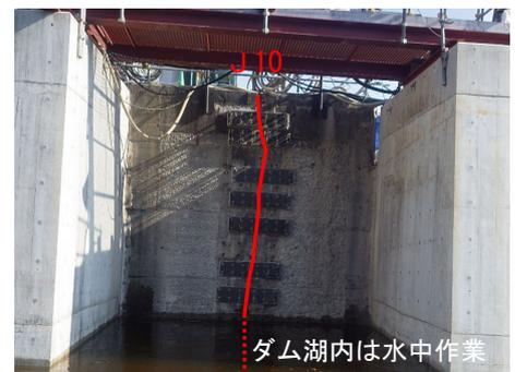
写真-1 変位抑制プレート（上流面）
