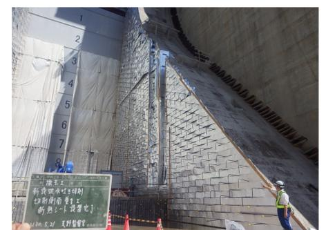
写真-3 断熱マット（切削側面）
