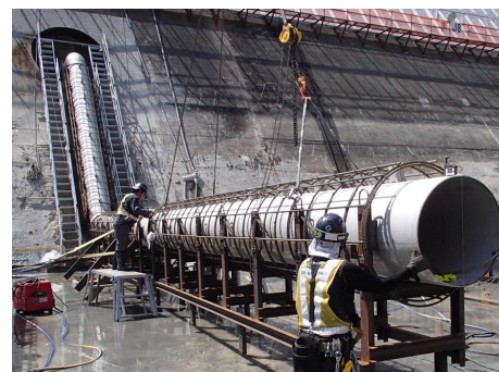
写真-1 導水管のユニット化
