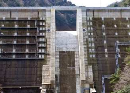
写真－6 堤頂部改造完了
