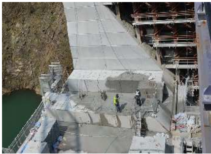
写真－4 コンクリート取壊し状況
