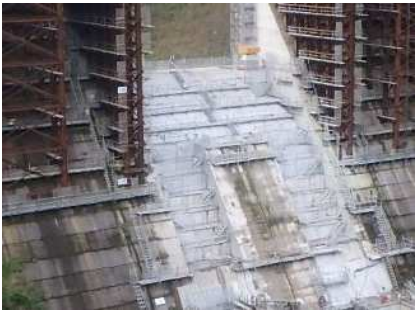
写真－3 堤頂部取壊し完了時
