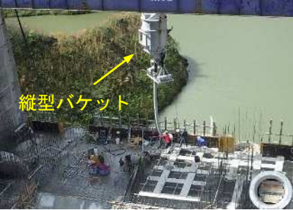
写真－5 コンクリート打設状況
