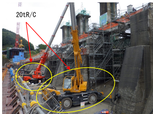
写真-2 20tR/C 設置状況
