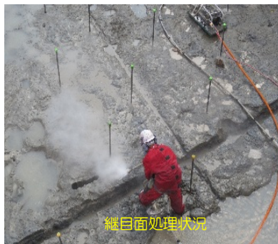
写真-1 超高圧ジェット水圧 200MPa による処理状況
