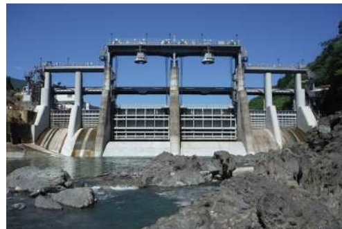
写真-2 改造工事完了
