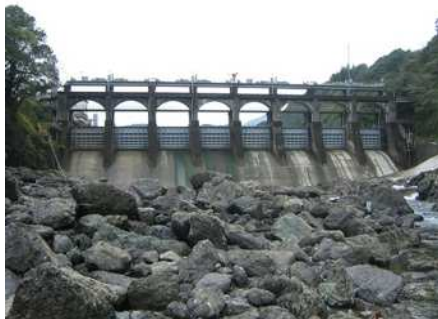
写真-1 改造工事着工前
