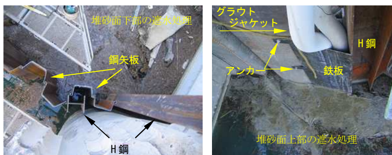
写真-3 鋼矢板と堤体接合部の処理状況
