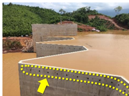
写真-4 ラビリンス式洪水吐のエアレーター
