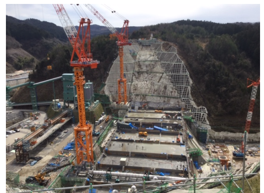
図-5 クレーン配置状況
