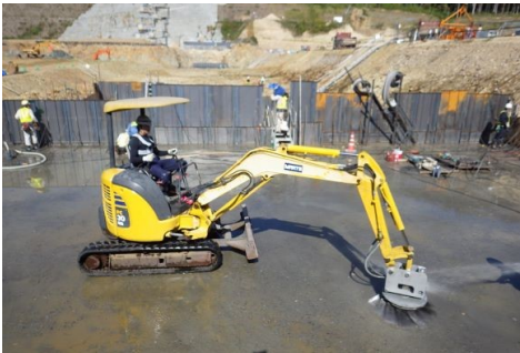
写真-1 グリーンカット施工状況
