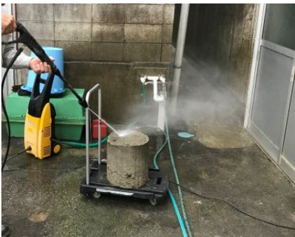
写真-2 グリーンカット施工状況
