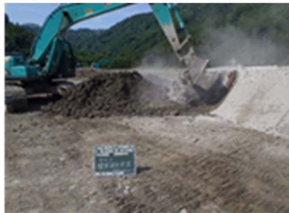
写真-2 汚泥の固化処理盛土整形状況
