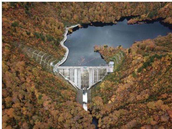
写真-1 奥胎内ダムサーチャージ到達状況(下流より望む)
