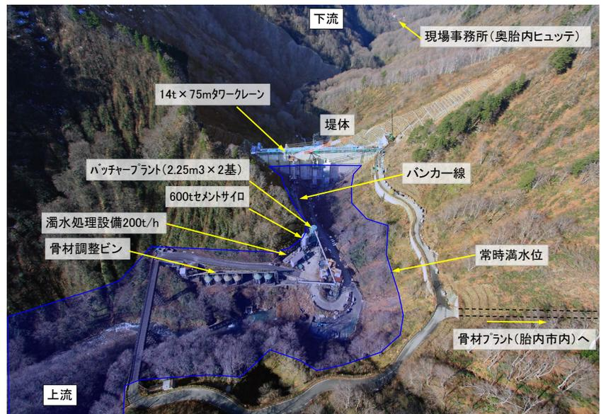
図-3 ダムサイトダム用仮設備の等配置状況
