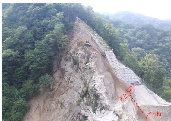
写真-2 RCM(ロッククライミング)工法による 3次掘削(切り直し掘削)状況
