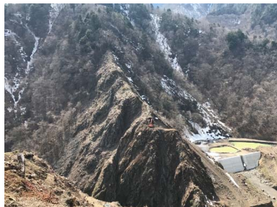
写真-1 右岸やせ尾頂部掘削状況
