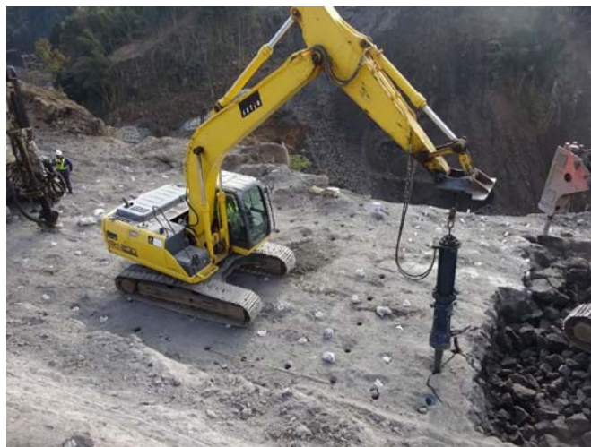
写真-2 油圧クサビ挿入状況
