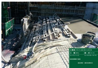
写真-7 真空ポンプ吸引状況
