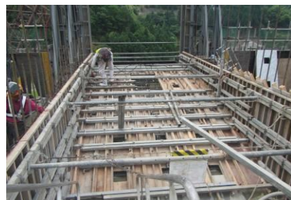
写真-6 真空型枠組立状況
