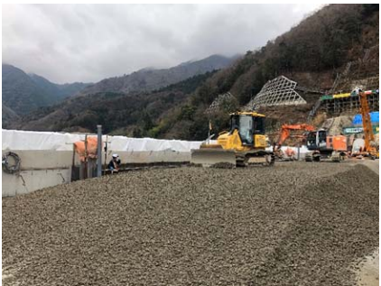
写真-4 狭隘部(40mmRCD)敷均し
