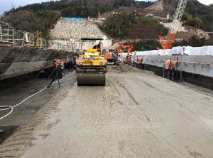
写真-5 狭隘部 RCD 施工状況
