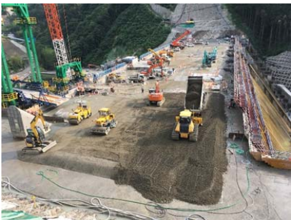
写真-1 巡航RCD施工全景
