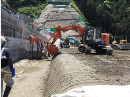
写真-2 端部法面締固め
