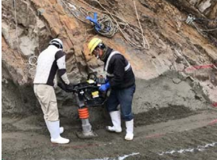
写真-6 着岩部 RCD 施工状況
