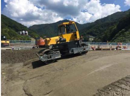
写真-3 傾斜打止め転圧
