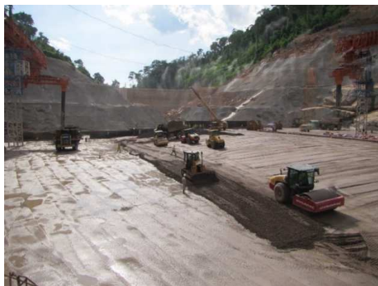
写真-1 RCCの施工状況
