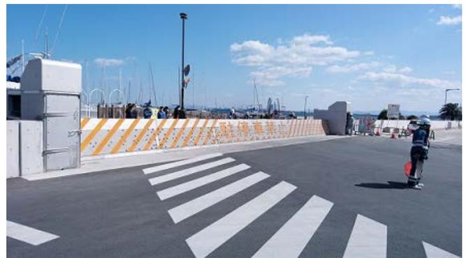
図-3 構造概要・陸閘の作動状況
