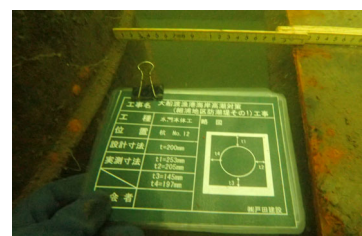
写真-4 導材と杭の離隔確認
