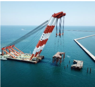
図-5 作業用仮設構台設置
