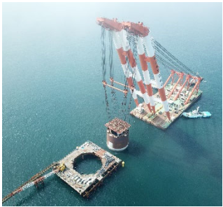
図-6 鋼殻ケーソン設置
