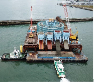
図-7 土砂搬出状況
