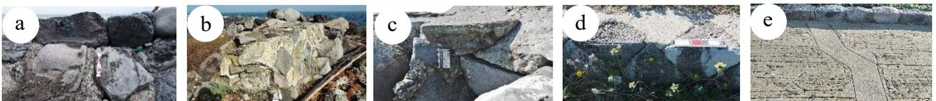
図 2：第一海堡の護岸構造物 (a) 北側防波堤(明治 16 年以降), (b) 防波堤東側締切部(明治 35 年), (c) 法面被覆コンクリート(明治 19 年)と周回道路モルタルの断面(震災後か), (d) 新規護岸路面被覆モルタル(震災後), (e) 小口モルタル(震災後)
