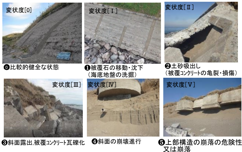
図-2 第一海堡の護岸の代表的な変状状況
