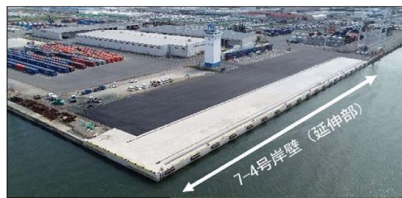
図-5 完成した三河港神野地区耐震強化岸壁
