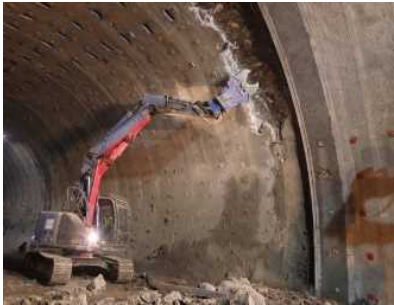
写真－２ 縫い返し施工状況
