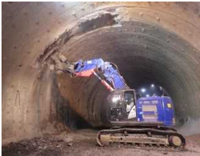
写真－２ 縫い返し施工状況
