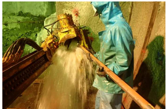
写真-1 コアボーリングからの湧水状況
