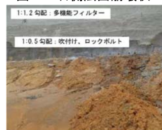
図-4 湧水による土砂流出
