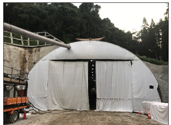
写真-1 機械掘削時の騒音対策
