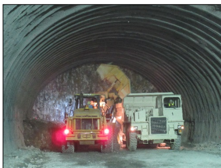
写真-2 サイドダンプ方式による積込み
