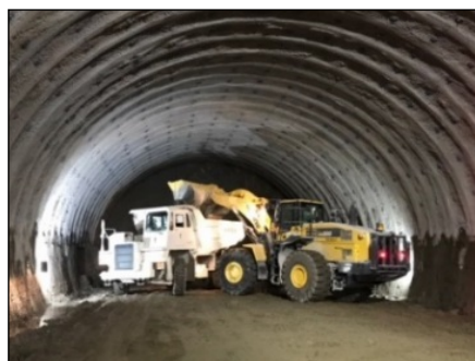
写真-3 フロントダンプ方式（左積）
