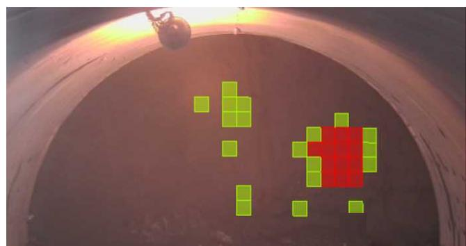
図-5 デモ吹付け後ウェアラブル端末内の AR 映像
