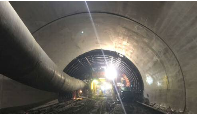
写真-5 脱型後の仕上がり状況
