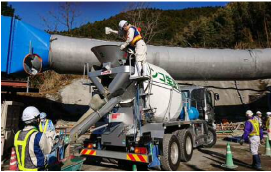
写真-3 流動化剤の投入状況
