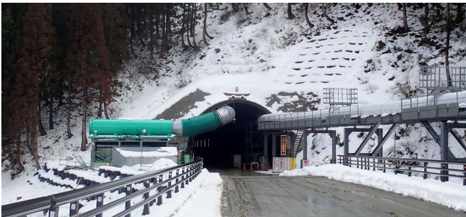
写真-1 現場状況
