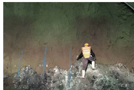
写真-1 装薬孔の穿孔位置決め
