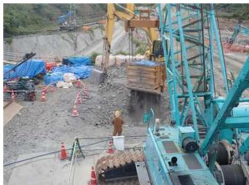
図5 3m<sup>3</sup>ズリバケツによるズリ出し状況(地上)
