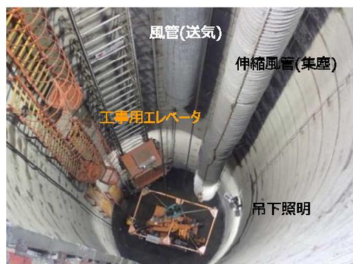
図6 坑内仮設備配置状況
