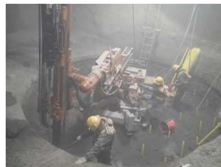
図3 小型油圧ドリルによる装薬孔穿孔状況
