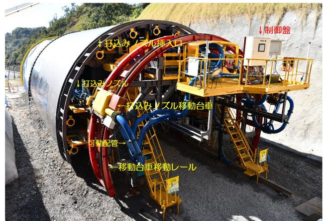
写真-2 マニピュレータ方式自動打込み装置全景
