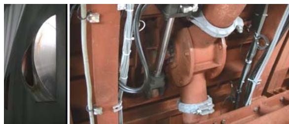
写真-1 新しい打設配管システムの装置
