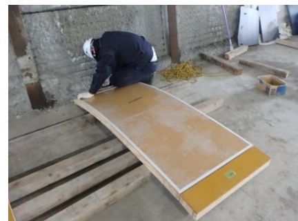
写真－2 シート貼り付け状況
