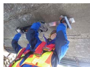
写真-1 計測状況
