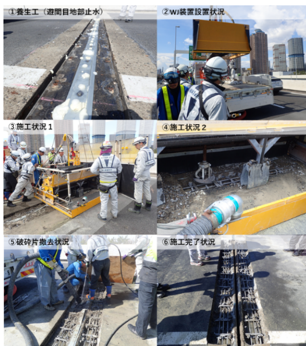
写真-4 第3回試験施工状況
