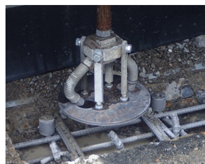
写真-2 噴射ノズル
