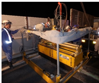
写真-1 WJ装置全景
