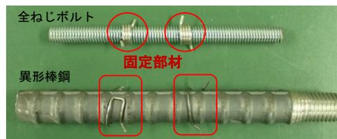
写真-1 固定部材を取付けたアンカー筋
