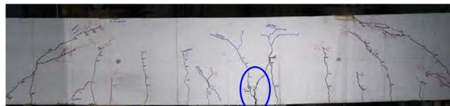
図-7 FL試験体破壊状況 (N=412, 737回)
