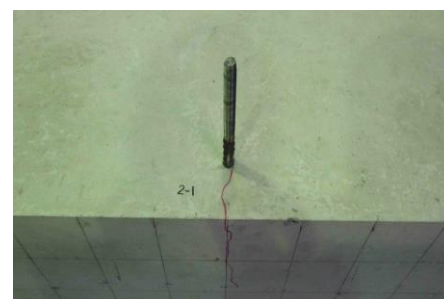
図-3 ひび割れ状況の例 (D16-5D-1)
