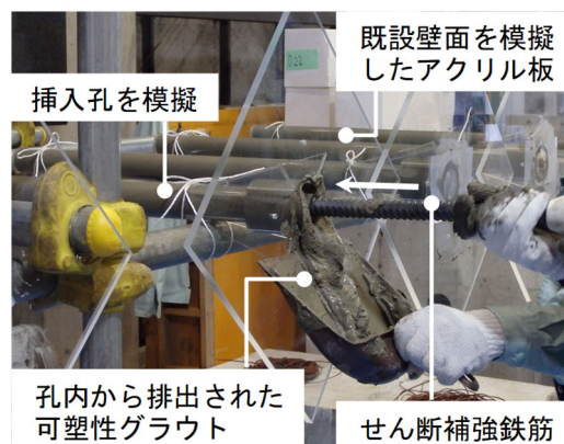
写真-3 可塑性グラウトを用いた施工
