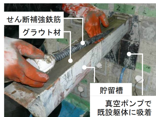
写真-1 貯留槽を用いた横向き施工
