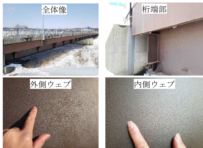
写真 1 供用 15 年後の橋梁外観
