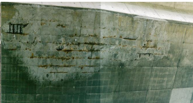
写真-3 箱桁下床版下面の状態
