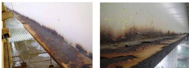
写真-1 鋼材の腐食状況
