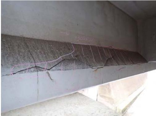
図-3 損傷状況（脱塩実施径間-下フランジ）
