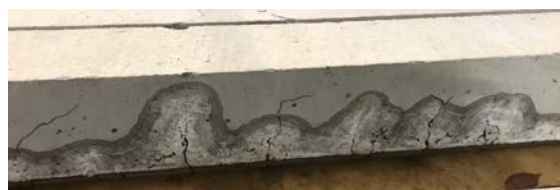
図-2 塩水吸い上げ状況(ひび割れあり)
