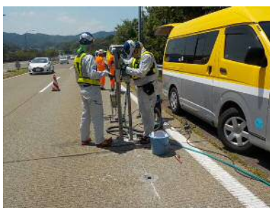
写真-1. 削孔状況
