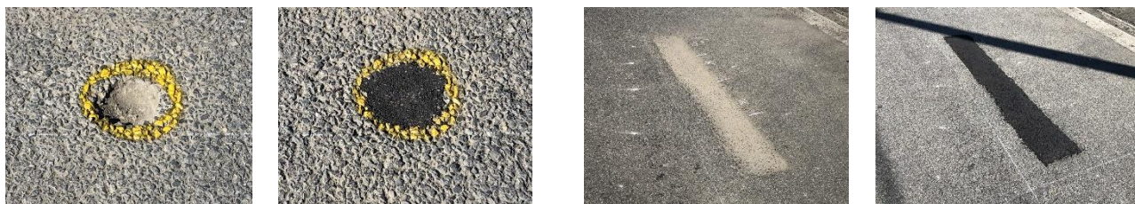
模擬ポットホール（左：補修前、右：補修後）
